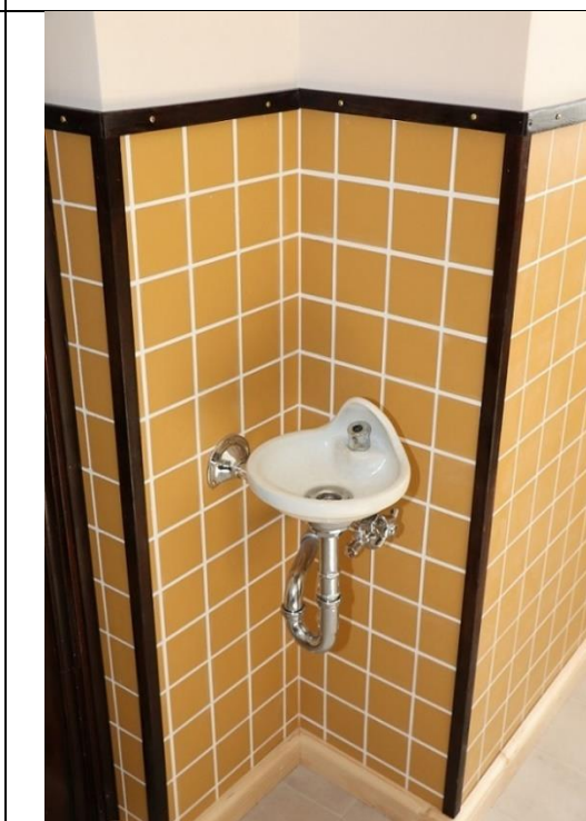
Iliustracija Nr. 38. Gertuvė – vandens fontanas po restauravimo. Vienas pirmųjų tokio tipo prietaisų Lietuvoje.
